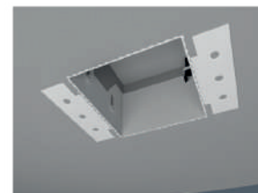
Corte o gesso na medida correta.
