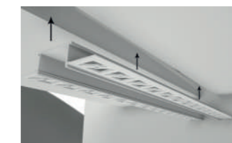
Encaixe o perfil sem o difusor no local.
