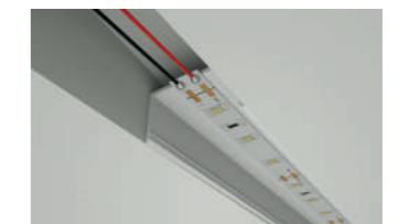
Faça a ligação elétrica com a fonte da Fita led.
