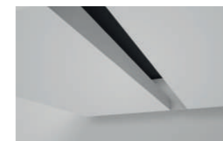
Abrir o gesso com a largura adequada.
