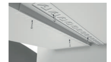
Parafuse o perfil no gesso conforme ilustração.
