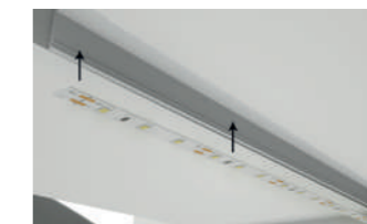
Aplique a fita led com fita adesiva no interior do perfil.
